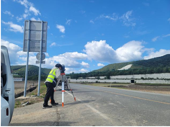
광파기를 이용한 측량 작업사진
